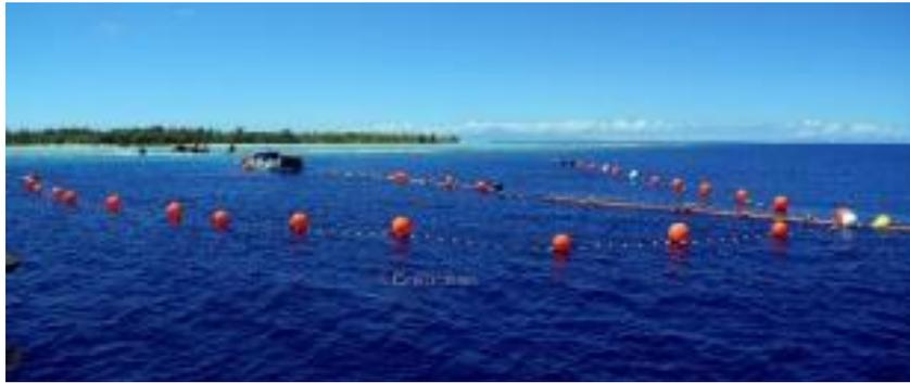
*Figure 5.14.2 : Pose du pipe du SWAC de l'hôtel Brando de Tetiaroa (Polynésie Française). Pacific Beachcomber (PBSC) maître d'ouvrage à travers la principale société du groupe Tahiti Beachcomber SA (TBSA) du SWAC à Tetiaroa (second après celui de Bora Bora qu'elle a également construit). CREOCEAN SA : maître d'œuvre du projet, a assuré la réalisation des études préalables, la conception du système et le suivi des travaux de construction du SWAC.*
