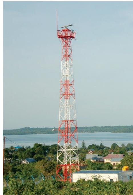
Le radar enregistre ainsi un écho et par répétition des mesures dans le temps, l'ensemble des échos forment des pistes radar. Le radar permet ainsi la détection d'objets. L'identification des objets nécessite d'exploiter des données complémentaires (AIS, imagerie).
