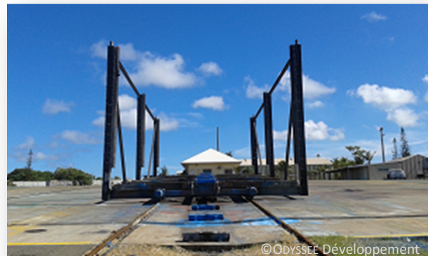
Photo 9 Slipway 200 tonnes du PANC
