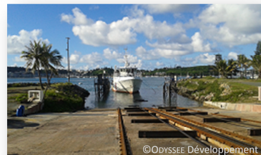
Photo 11 Slipway 1 000 tonnes du PANC
