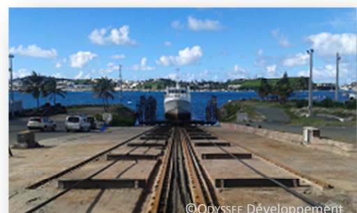
Photo 12 Slipway 1 000 tonnes du PANC
