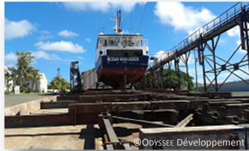
Photo 8 Silpway 1 000 tonnes du PANC
