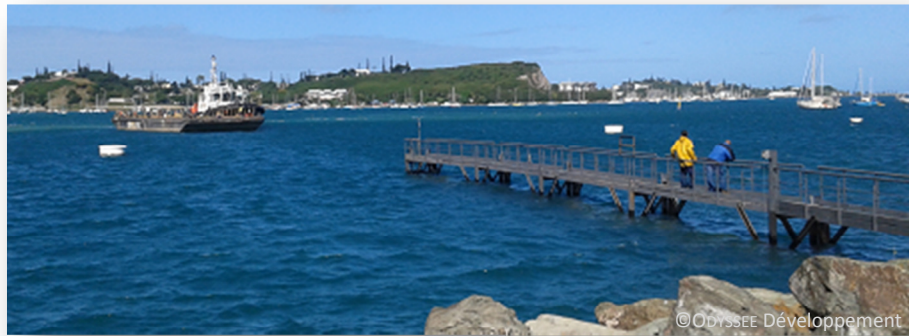
Photo 10 Slipway 1 000 tonnes du PANC
