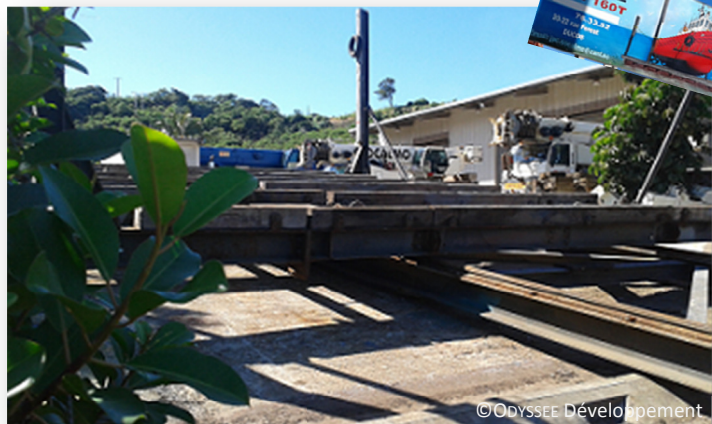
Photo 5 Slipway de la société Socalmo
